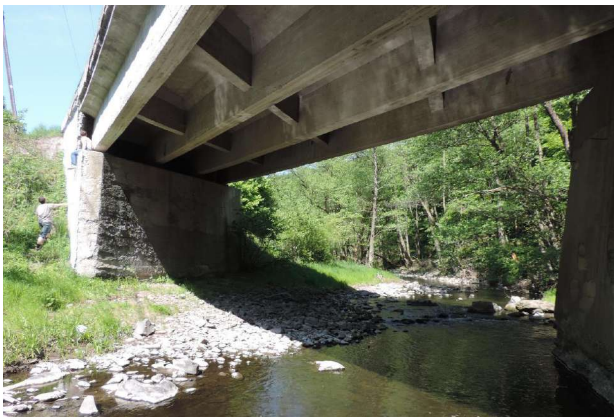
Obrázok č. 1.17: Most v lokalite Krnišovský mlyn, významný úkryt podkovárov malých je dnes v oprave a ochrane podmostového priestoru treba venovať značnú pozornosť
